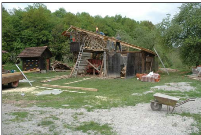
Slika 7: Obnova kozolca v letu 2011. Foto: D. Štepec, april 2011. Arhiv ZVKDS – OE Novo mesto.
