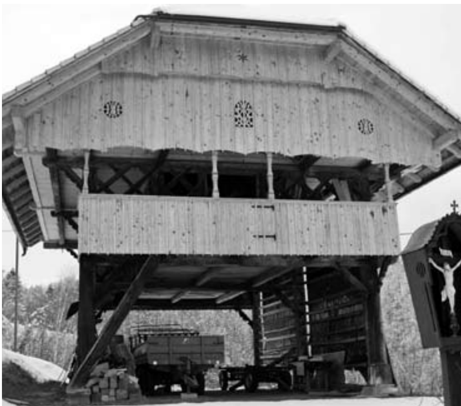
Leta 2011 obnovljeni Škodatov kozolec toplar v Dolu na Hrastnem, ki ga je leta 1948 postavil tesarski mojster Ivan Karlič z Velikega Cirknika; zatrepe s cvetličnim vzorcem oz. kapelco sta naredila tesarski mojster Slavc Brcar s Homa ter Ramovš s Hrastnega. Zračne line so bile obnovljene po vzoru prejšnjih. Foto Mojca Ramovš, 2013.
