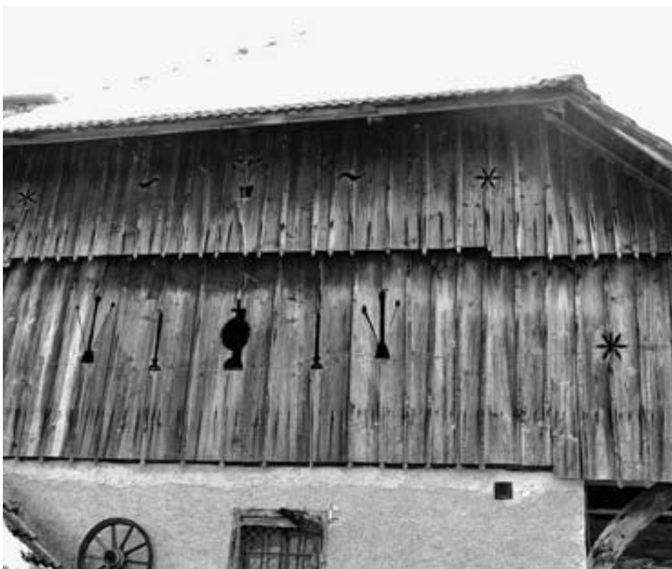
Hlev s podom pri družini Jene v Križu blizu Telč je delo tesarskega mojstra Franca Karliča. Narejen je bil v 30. letih 20. stoletja ter ima značilne očetove vzorce zračnih lin - ptički, monštranca, svečnik. Foto Mojca Ramovš, 2013.
