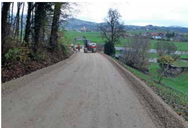
Sanacija Trstenik - Straža - Brinje, foto Urbing d.o.o.
