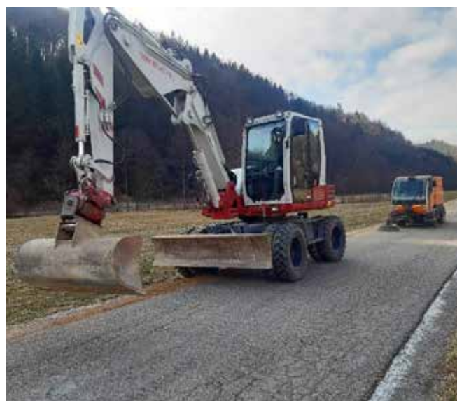
Redno vzdrževanje občinskih cest, foto: GM Marjan Slapšak s.p., 2022
