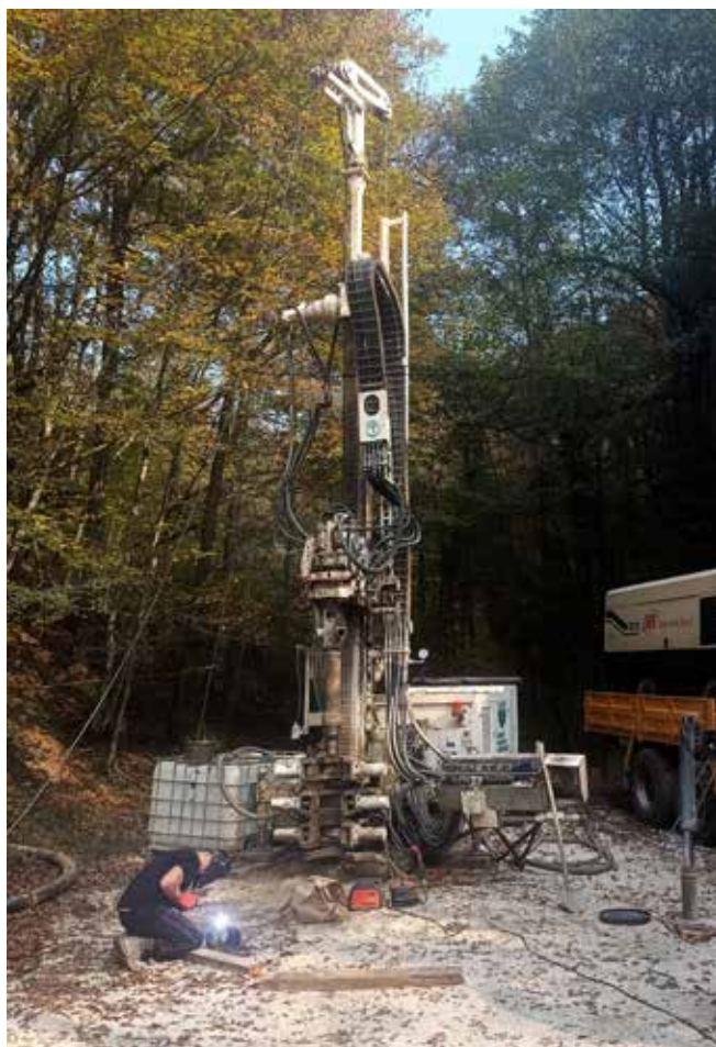
Vrtanje raziskovalne vrtine za nov vodni vir v Kamnju pri Šentrupertu (foto arhiv podjetja Geo-Hidro, d.o.o., 2022)
