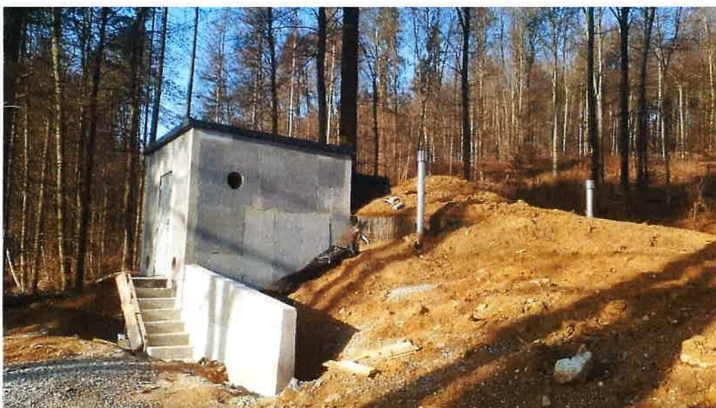
Slika 4: Obnova vodohrana Brezovica 2018
